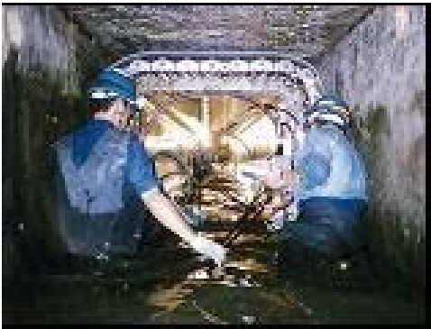
内面被覆による管きよの補強
