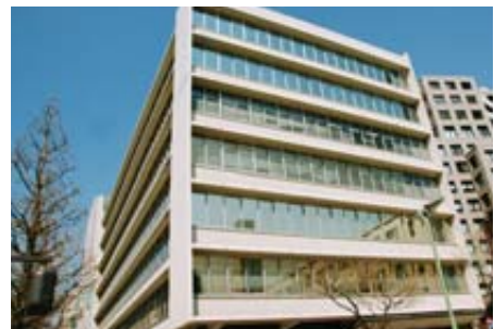
耐震補強工事を行う市役所第2庁舎
