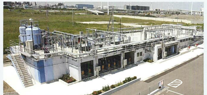
施設全景(その2工事)
