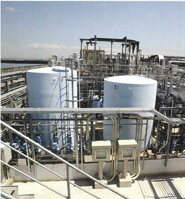
施設全景(その1工事)
