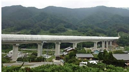
防音防災フードの設置の例
