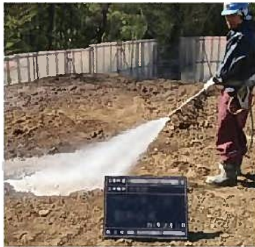
工事現場における散水の例
