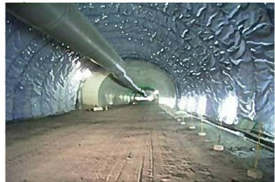
適切な構造の採用（防水シート）の例
