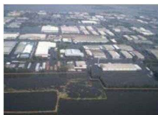
平成23年9月チャオプラヤ川 (タイ)ロジナ工業団地の浸水
