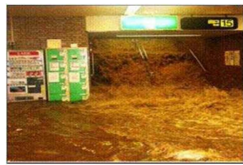
平成15年7月 地下鉄博多駅の浸水
