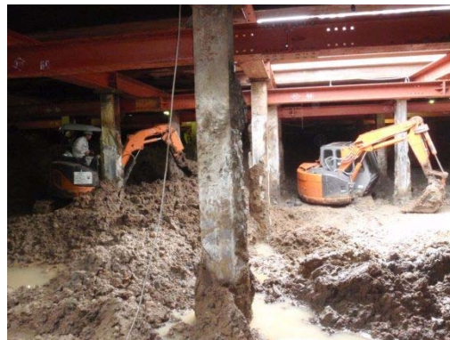
掘削した土砂の状況
