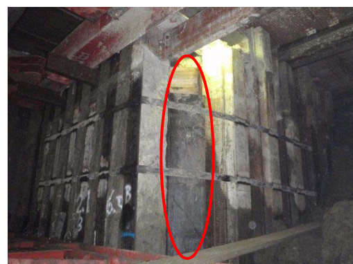
追加した止水壁(中央部)
