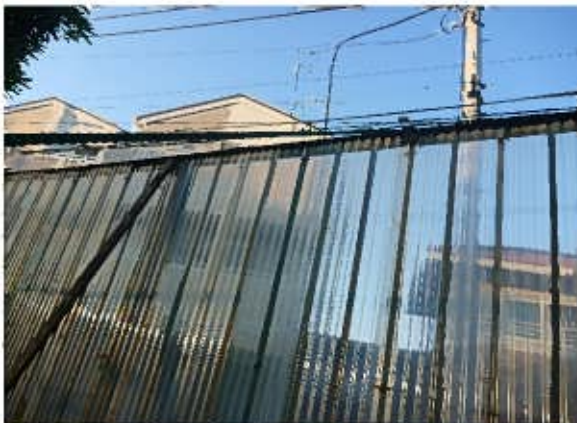
③ 学校フェンスに設置された ポリカーボネイト波板
