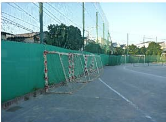
④ 防砂ネット設置状況
