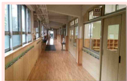
再生整備による内装改修
