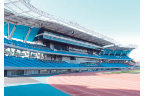
メインスタンドが改修された等々力陸上競技場(中原区)
