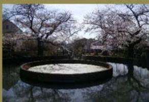
二ヶ領用水久地円筒分水
