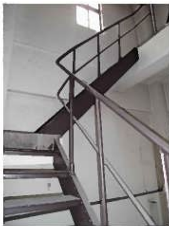
時計塔内部の鉄骨階段（4階より上部）
