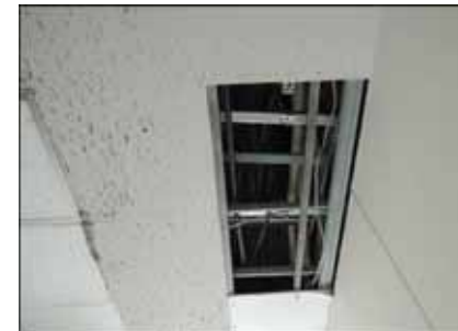
天井内埋設配線・配管調査時
