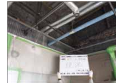
アスベスト撤去前
