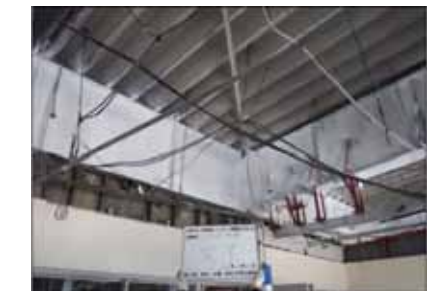
アスベスト撤去後
