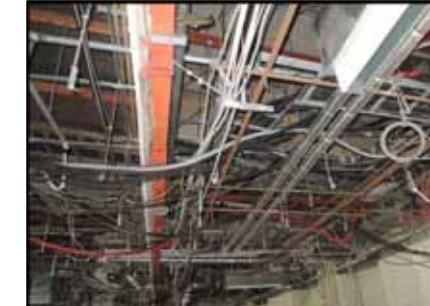
天井内埋設配線・配管撤去時
