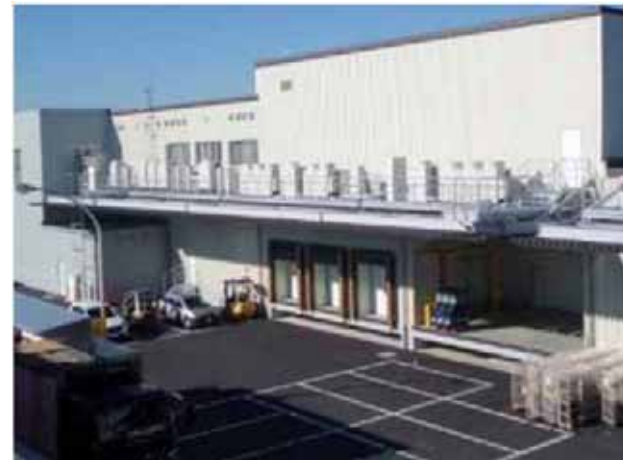
民間活力により新たに整備した配送棟 (北部市場青果部)
