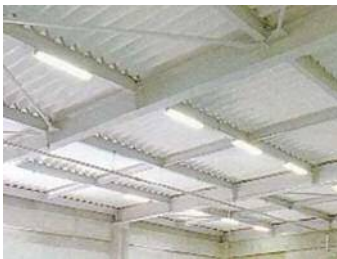
屋根用折板石綿断熱材
