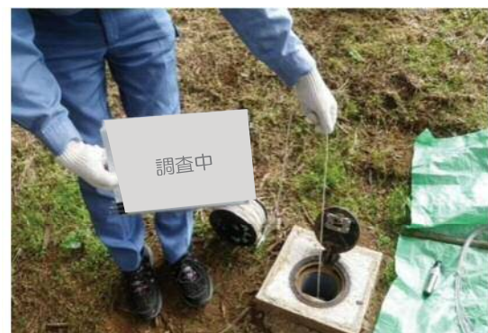
地下水位調査の例
