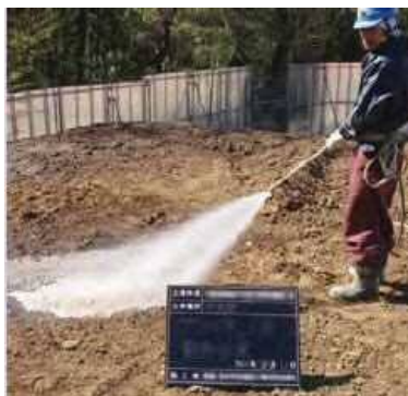
工事現場における散水の例
