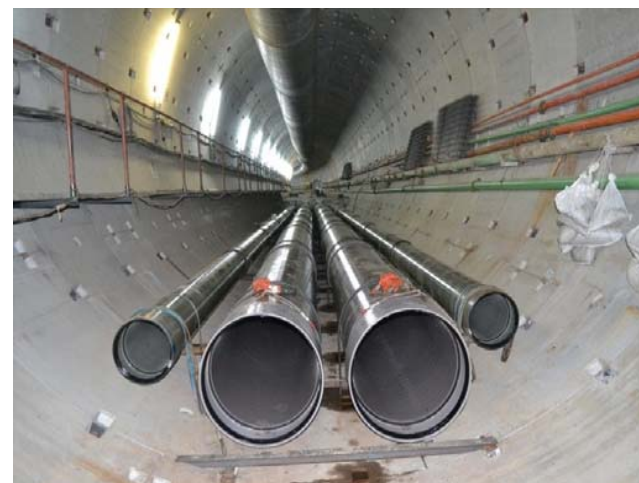
内挿管設置状況
