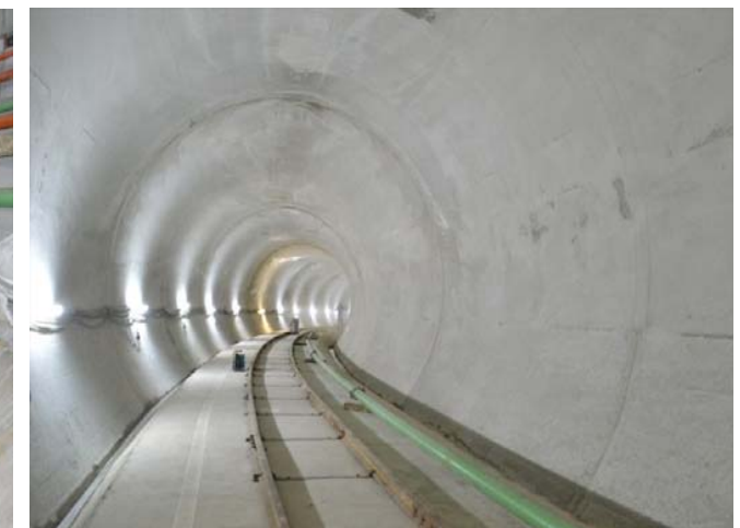
二次覆工完了
