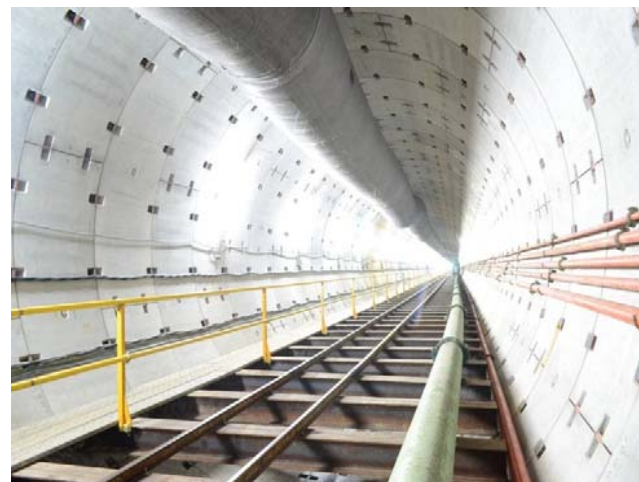
掘進完了(直線部)
