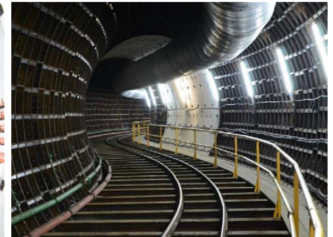
掘進完了(曲線部)
