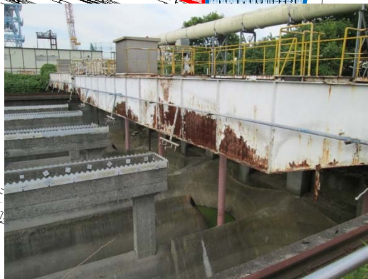
西系最終沈殿池 劣化状況
