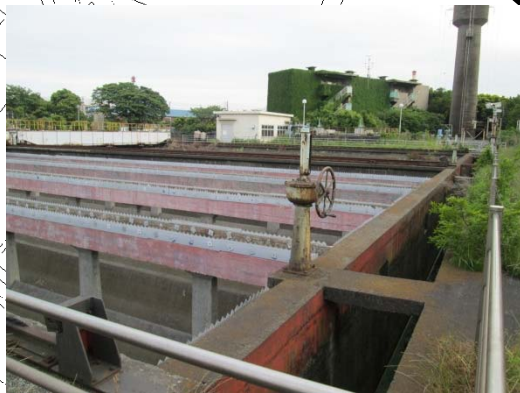
西系最終沈殿池 劣化状況
