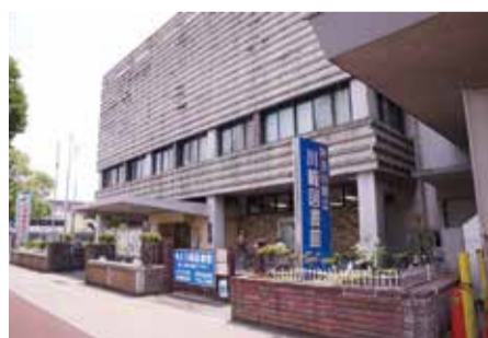
県立川崎図書館(川崎区)
