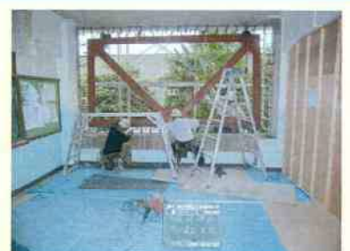
施設(学校)の耐震化工事 作業状況
