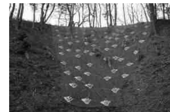
緑地保全と斜面安定の両立（ノンフレーム工法）
