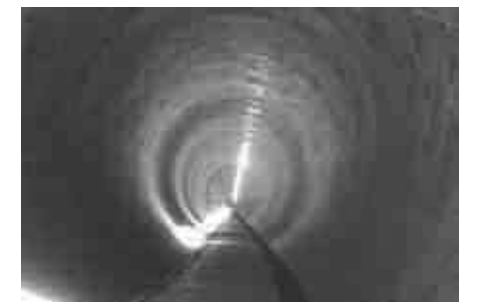
トンネル部状況
