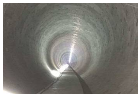
トンネル部状況
