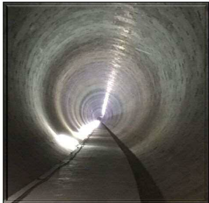
①トンネル部
