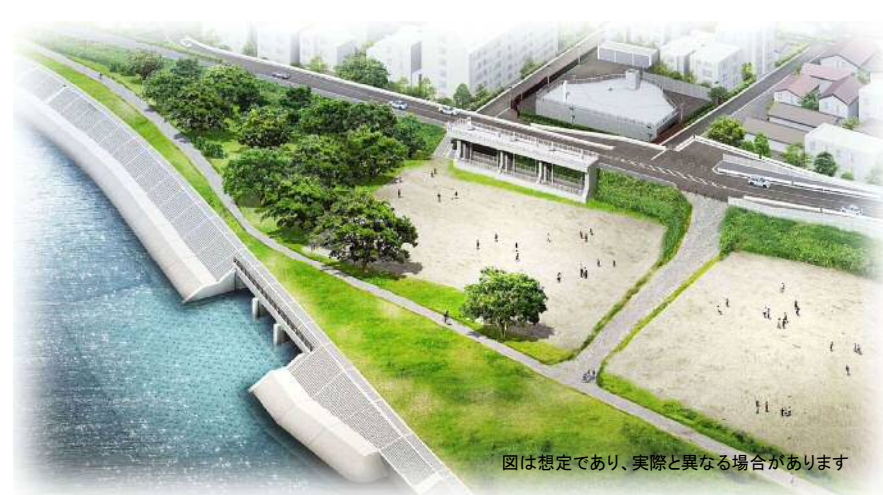
②五反田川放水路放流部樋門堤外水路(完成イメージ)
