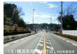
(主) 横浜生田(菅生付近) H22年度完成
