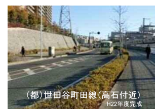
(都) 世田谷町田線(高石付近) H22年度完成
