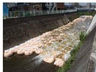
〔護岸ブロック間詰め・横断管の補修〕
