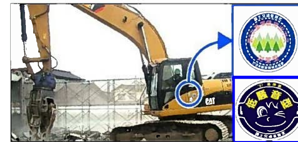
排出ガス対策型、低騒音型、低振動型建設機械の使用
