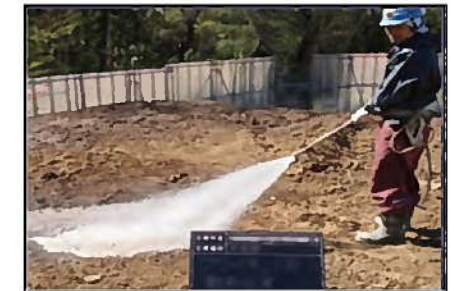
工事施工ヤード等の清掃、散水
