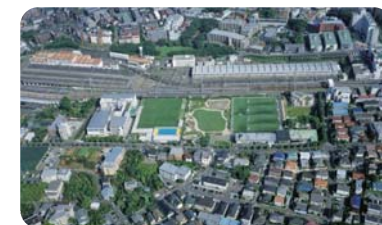
鶯沼配水池 昭和42年10月に完成した本市最大の配水池です。また上部を広場、フットサルコート、小学校校庭として利用しています。平成27年度に耐震補強工事が完了しており、有効容量は約11.0万m 3 です。
