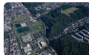
生田浄水場 昭和37年に通水を開始しました。処理方法は超高速凝集沈殿処理方式、施設能力は20万m 3 /日です。再構築計画により調整池などを建設しました。
