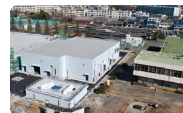
平間配水所 工業用水を使用する工場などが多く立地する臨海部への配水量や配水圧力を調整しています。再構築計画により調整池などの更新工事を行い、平成28年度から本格運用を開始しています。
