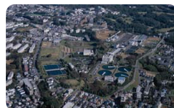
長沢浄水場 昭和29年6月に通水を開始しました。相模川を水源とし、処理方法は凝集沈殿処理方式、施設能力は25万m 3 /日です。再構築計画により調整池などを建設しました。
