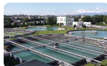
長沢調整池 再構築計画により建設し、平成22年度から本格運用を開始しています。
