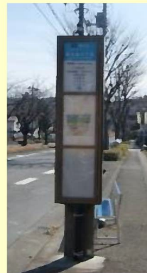
照明付標識 (LED化)
