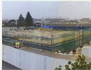
生田調整池築造（～平成22年度）
