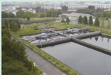
平間配水所調整池(昭和41年～)
