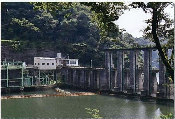
● 沼本ダム原水取水口
