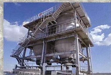
活性炭接触池新設(～平成27年度)
