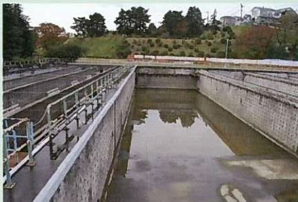
長沢浄水場沈でん池(昭和40年～)
