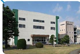
現在の活性炭注入棟
