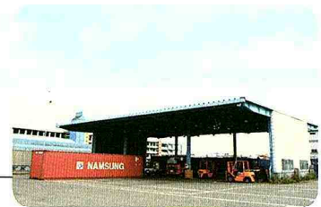
全天候型検査場 All-weather inspection Areas
