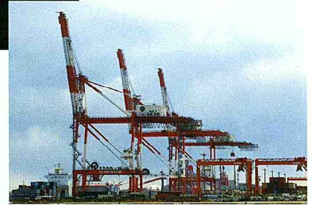
ガントリークレーン Gantry Crane
