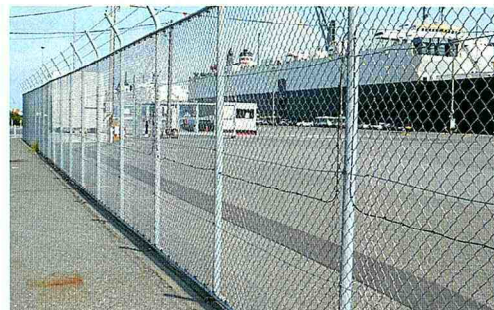
フェンスとゲート（東扇島外貿ふ頭）
