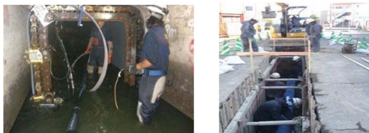
既設管の内面に新たな管を構築する耐震化(更生工法)
