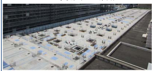
工事状況(2/2系列)
