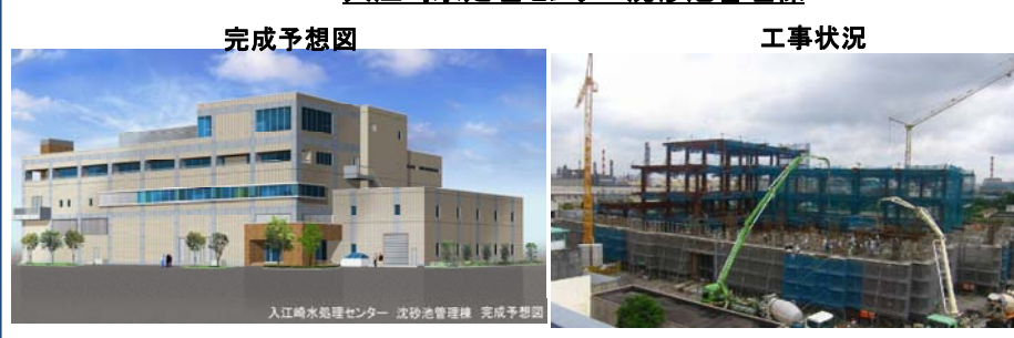
入江崎水処理センター沈砂池管理棟
