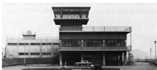
建設当時の入江崎水処理センター
