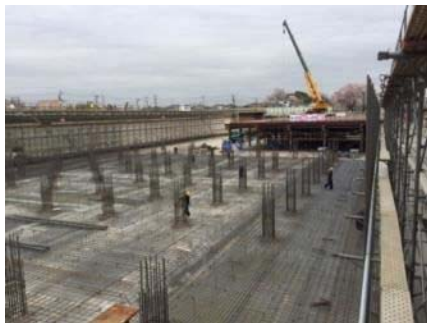
末吉配水池更新状況
