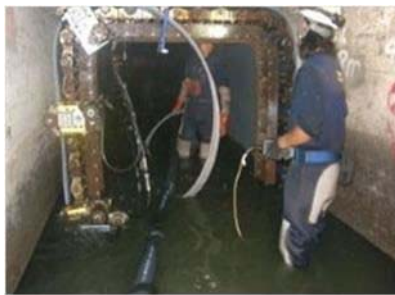
重要な管きよの耐震化（更生工法）
