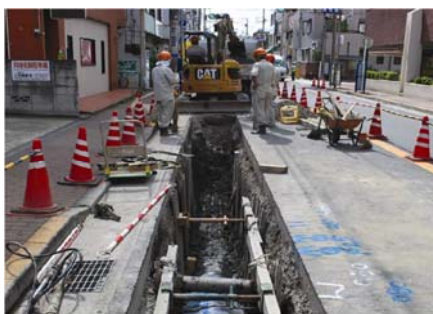
配水管布設替状況
