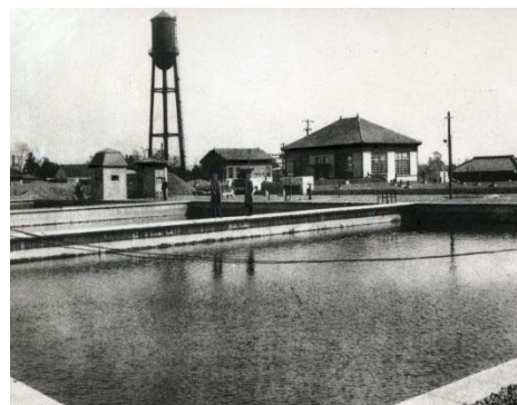
戸手浄水場（大正10年当時）
