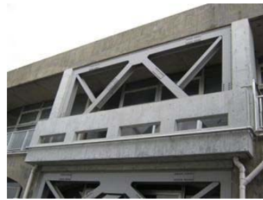
管理棟の耐震化（ブレースの設置）
