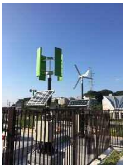
① 風力発電装置
