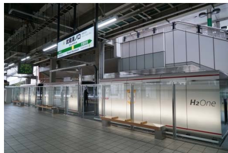
水素エネルギーの活用 (武蔵溝ノ口駅設置のH 2 O n e)
