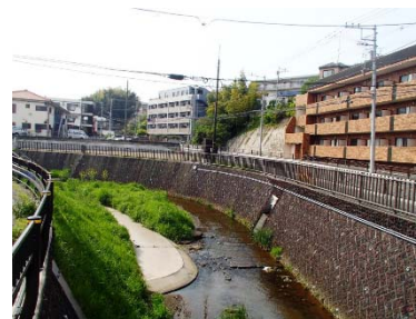
河川改修の状況（平瀬川支川）
