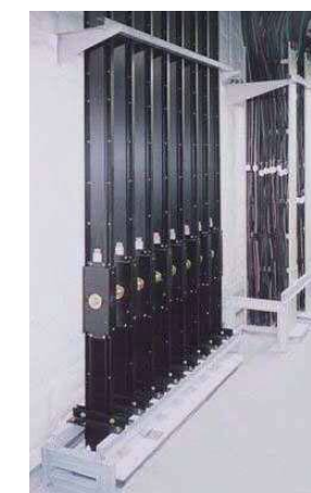
(例) バスダクト設置
