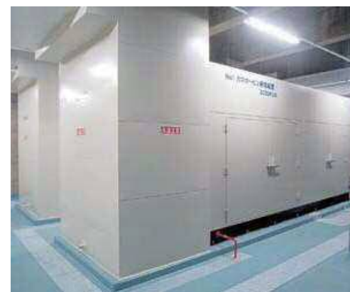
(例) 非常用発電機設置
