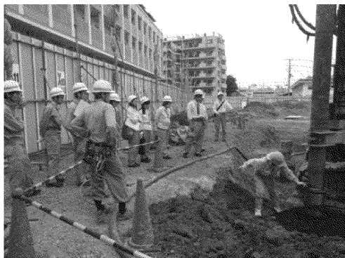
(杭工事施工確認)
