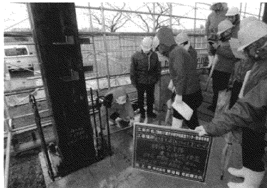
(鉄骨建方確認)
