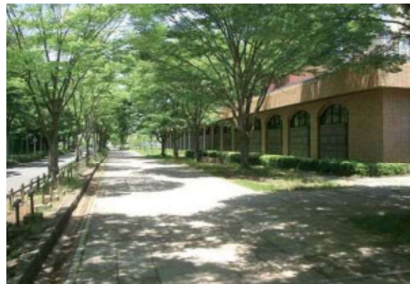
麻生水処理センター
