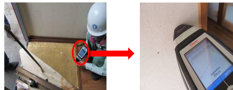
写真7 立入検査の様子 （携帯型測定器※を用いて建材を測定し、アスベストの含有を確認している。） ※アスベスト含有率が概ね1%以上のものについて測定可能
