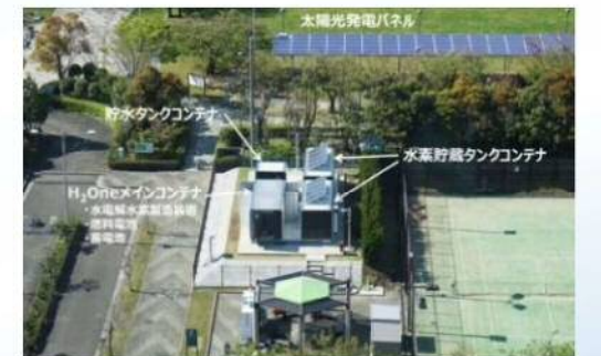
再生可能エネルギーと水素を用いた自立型エネルギー供給システム「H2One」(川崎マリエン)
