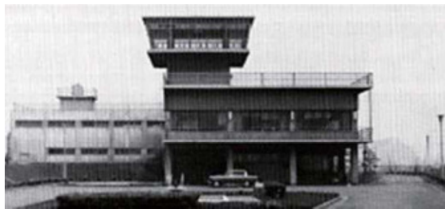
建設当時の入江崎水処理センター
