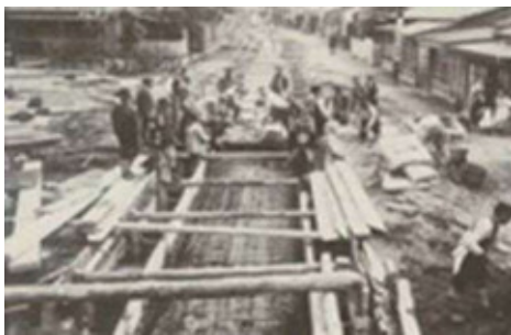
昭和初期の下水管きよの整備
