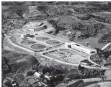
長沢浄水場(昭和29年当時)
