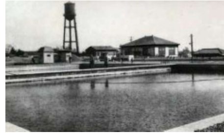
戸手浄水場(大正10年当時)
