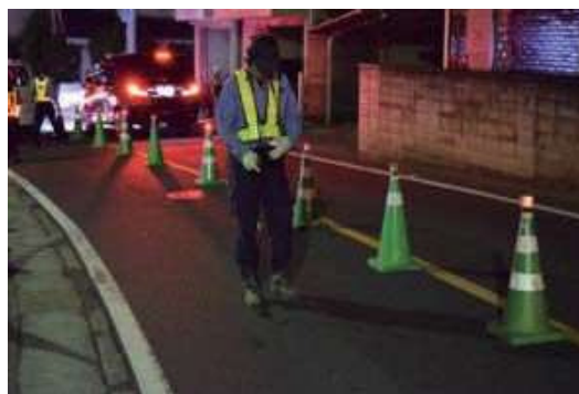
電子式漏水発見器による調査
