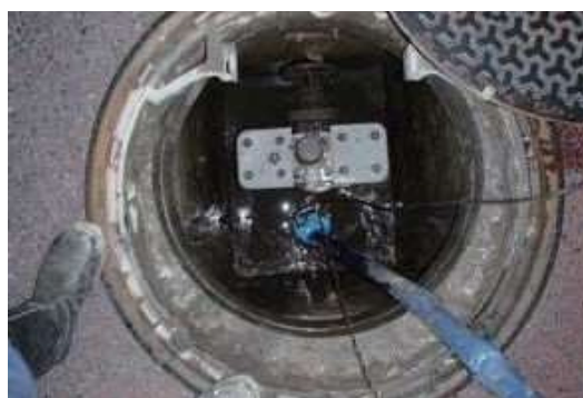
空気弁及び弁室内調査
