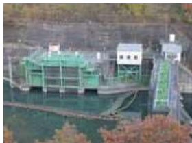
河川上流部から自然流下による導水が可能な沼本ダム及び取水口(標高121m)
