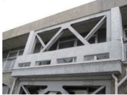
管理棟の耐震化(ブレースの設置)
