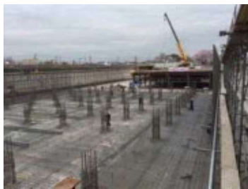
末吉配水池更新状況
