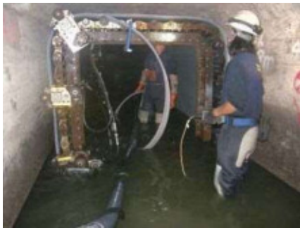
重要な管きよの耐震化(更生工法)
