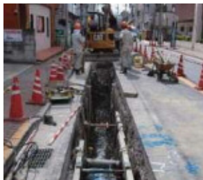
配水管布設替状況
