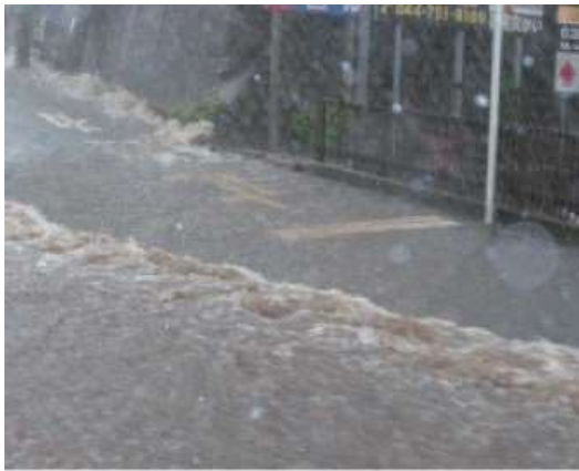
市内での浸水発生状況
