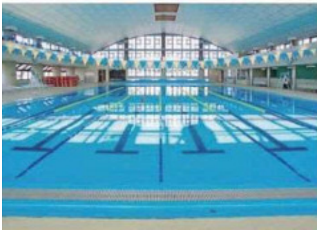
入江崎余熱利用プール
