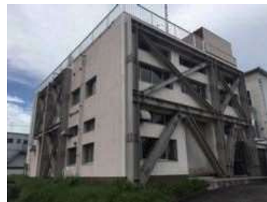
管理棟の耐震補強
