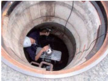
漏水検知センサ設置
