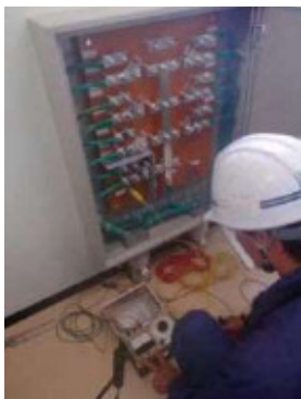
施設の点検(接地抵抗測定)
