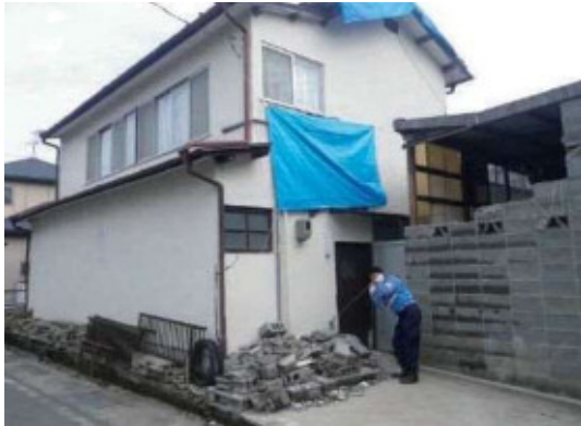
平成28年熊本地震に伴う被災地への職員派遣状況(配水管及び給水管の漏水調査及び修繕を実施)
