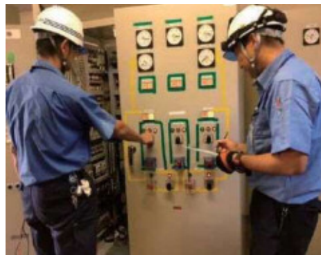
施設の点検(電動弁動作点検)
