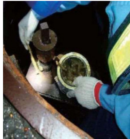
仕切弁ギア箇所保守点検
