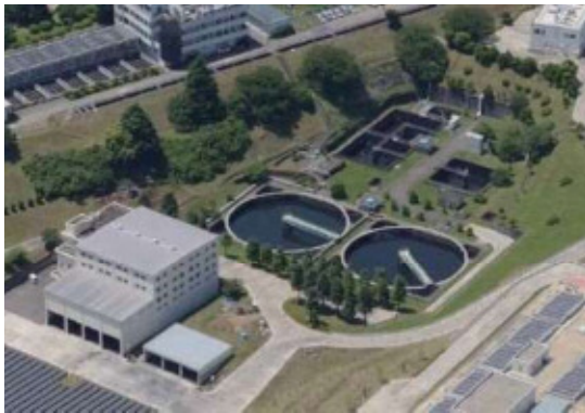
長沢浄水場排水処理施設
