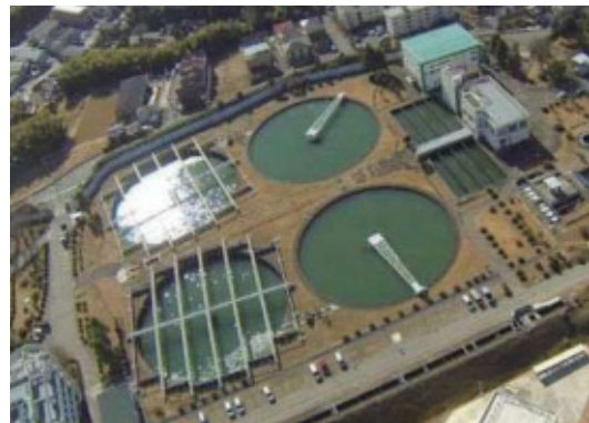
長沢浄水場第1沈でん池
