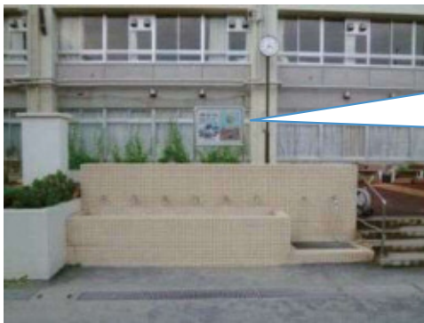
応急給水拠点の整備が完了した既設給水栓とPR看板の設置状況
