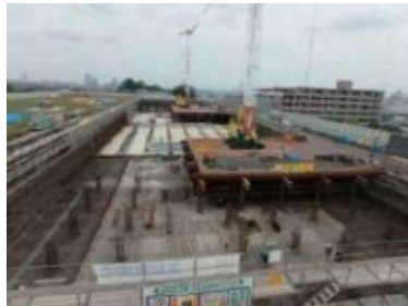
末吉配水池更新工事
