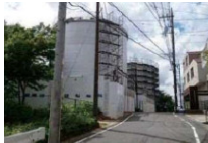
宮崎配水塔更新工事
