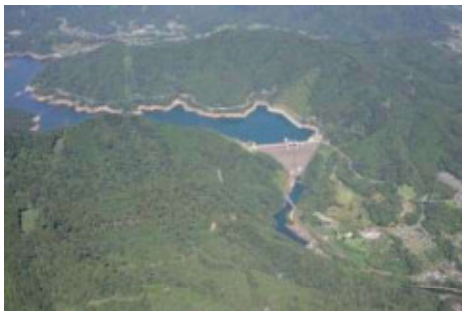
宮ヶ瀬ダム(宮ヶ瀬湖)
