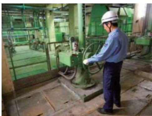
機器点検の実施状況
