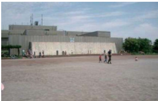
加瀬水処理センター (加瀬ふれあいの広場)
