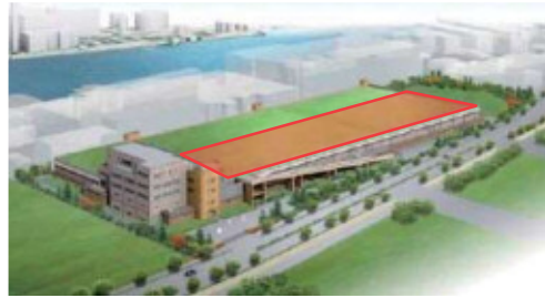
入江崎水処理センター 太陽光発電設備予定箇所
