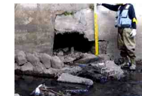
護岸背面部の空洞
