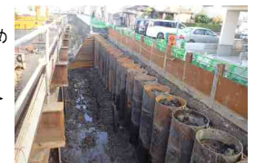
鋼管護岸へ更新中【市費にて対応】
