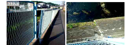
変状による護岸施設の目違い
