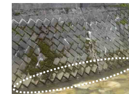
護岸の変状(ブロック隙間の拡大)
