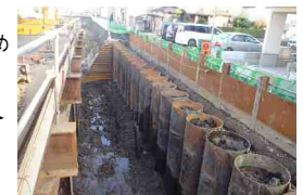
鋼管護岸へ更新中【市費にて対応】
