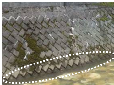
護岸の変状(ブロック隙間の拡大)
